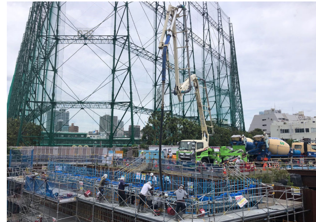
D: 新設橋梁工事
