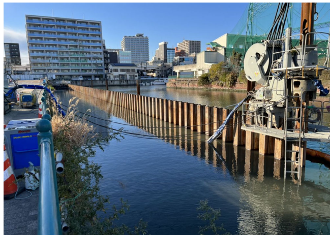
A: 区画道路12-1号線 護岸準備工事
