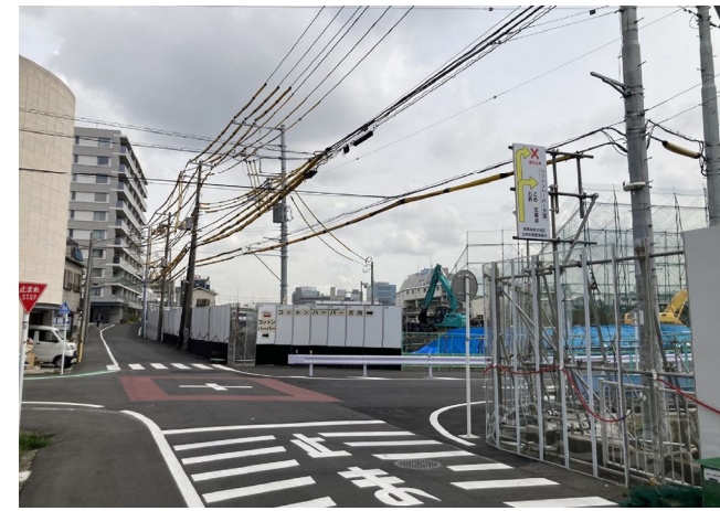
B: 龍宮橋線迂回路工事
