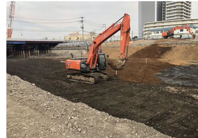
E: 運河埋立工事
