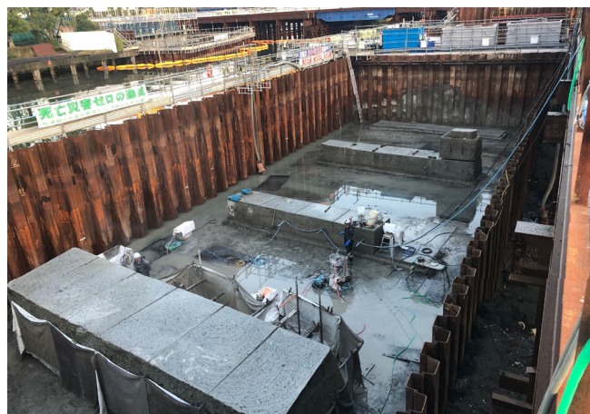
C: 龍宮橋撤去工事
