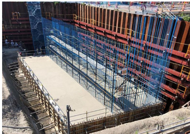
D: 新設橋梁工事
