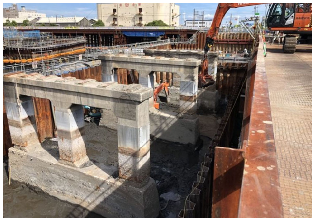
C: 龍宮橋撤去工事
