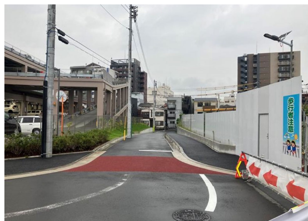
C: 区画道路6-2号線 道路工事
