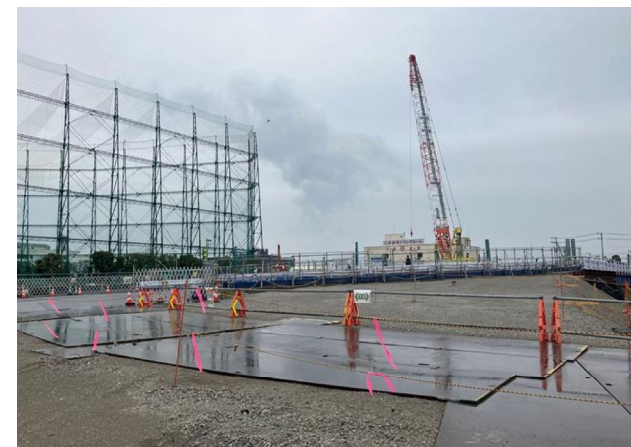
B: 龍宮橋線迂回路工事
