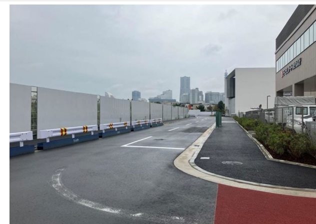
B: 区画道路12-2号線 道路工事
