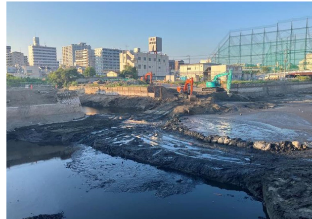
E: 運河埋立工事
