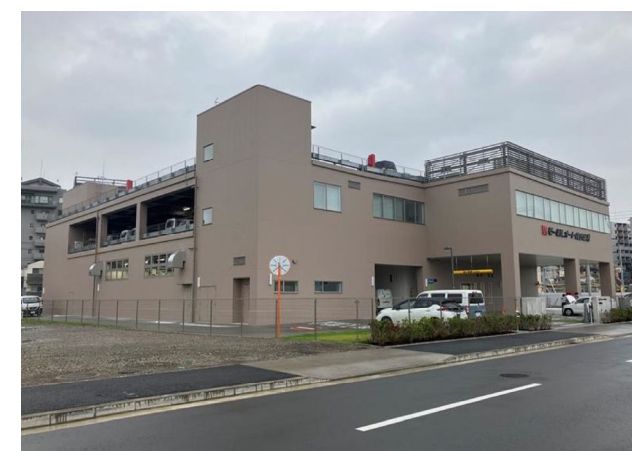
E: 区内建築工事②
