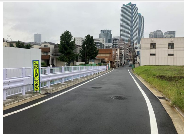
A: 区画道路6-1号線 道路工事
