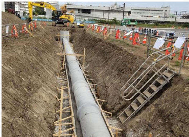
A: 区画道路12-2号線 道路工事
