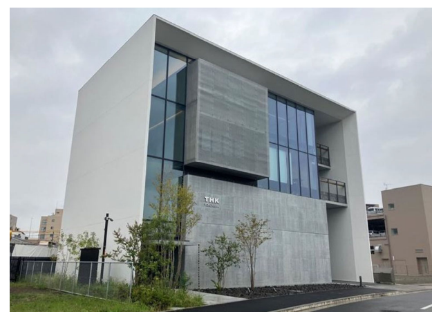
D: 区内建築工事①
