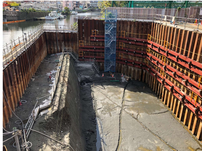
A: 新設橋梁工事 (A1)
