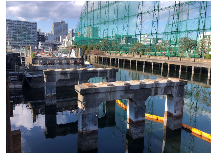
B: 龍宮橋撤去工事
