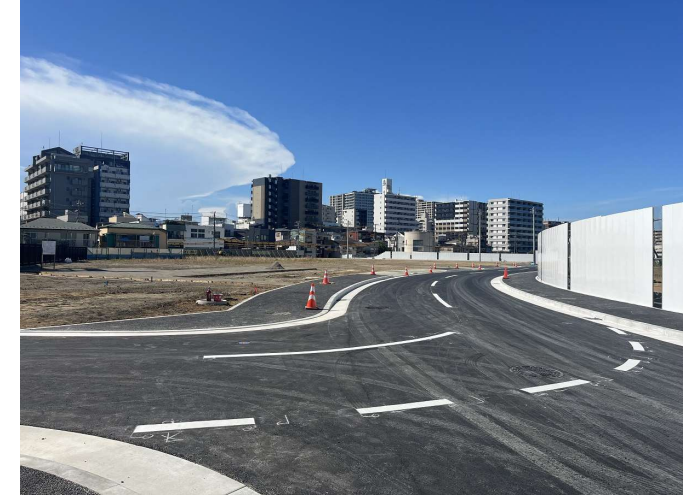
E: 区画道路工事
