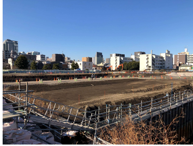
D: 運河埋立工事
