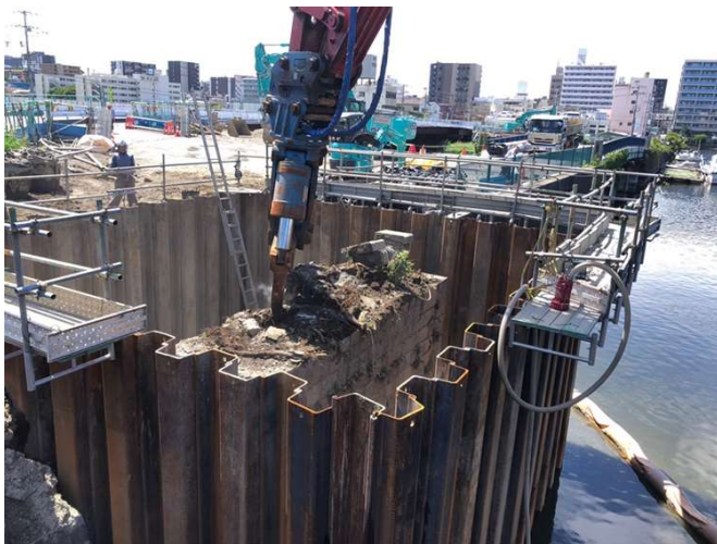
C: 鉄道橋撤去工事
