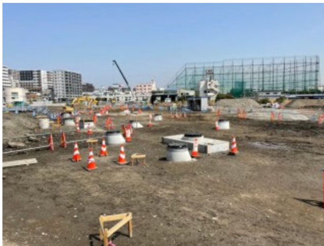
B:雨水污水排水工事
