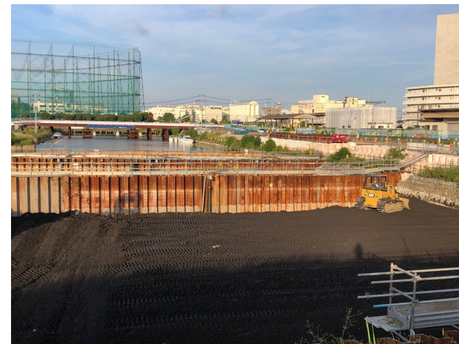
C:運河埋立工事
