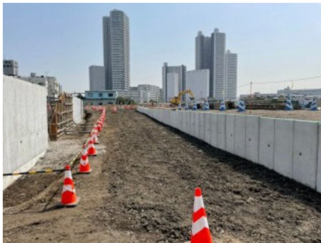
A:擁壁工事
