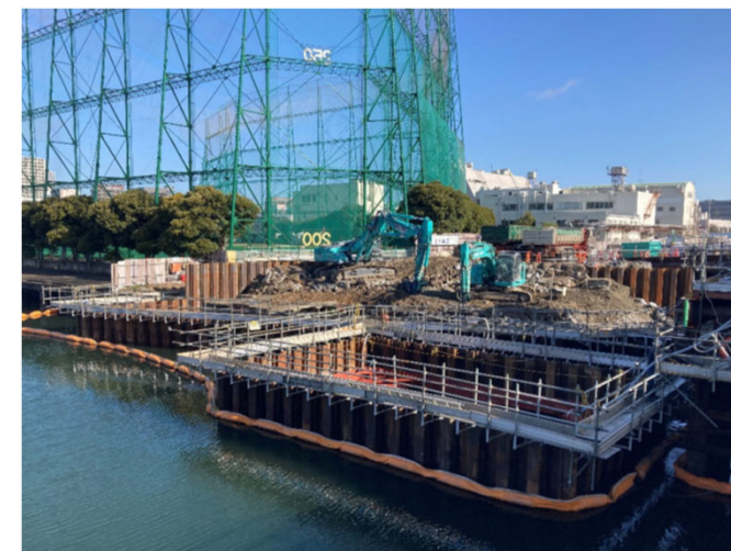
F:鉄道橋撤去工事
