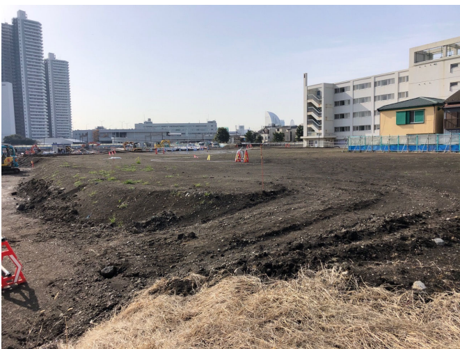
D:宅盤造成工事
